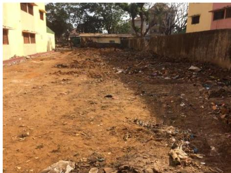
...qui est prête pour que les ouvriers fabriquent sur place les parpaings, préparent les ferrailles et creusent les fondations !
